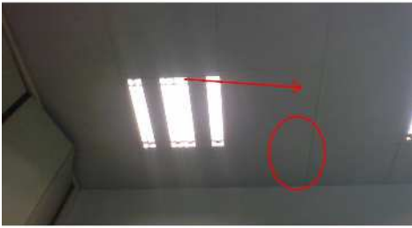
Contrôle n°11 - Photo n°1
